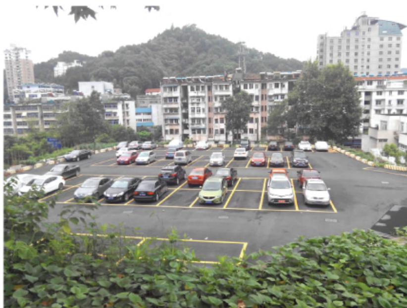
已投入使用的无线电厂区块停车场一期
