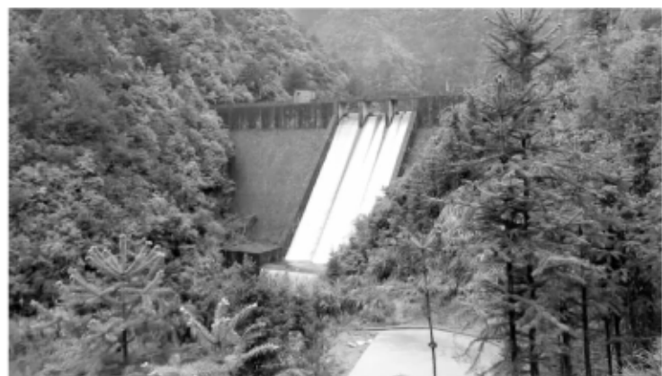
图为20日下午,寿昌镇考坑坞水库溢洪。
