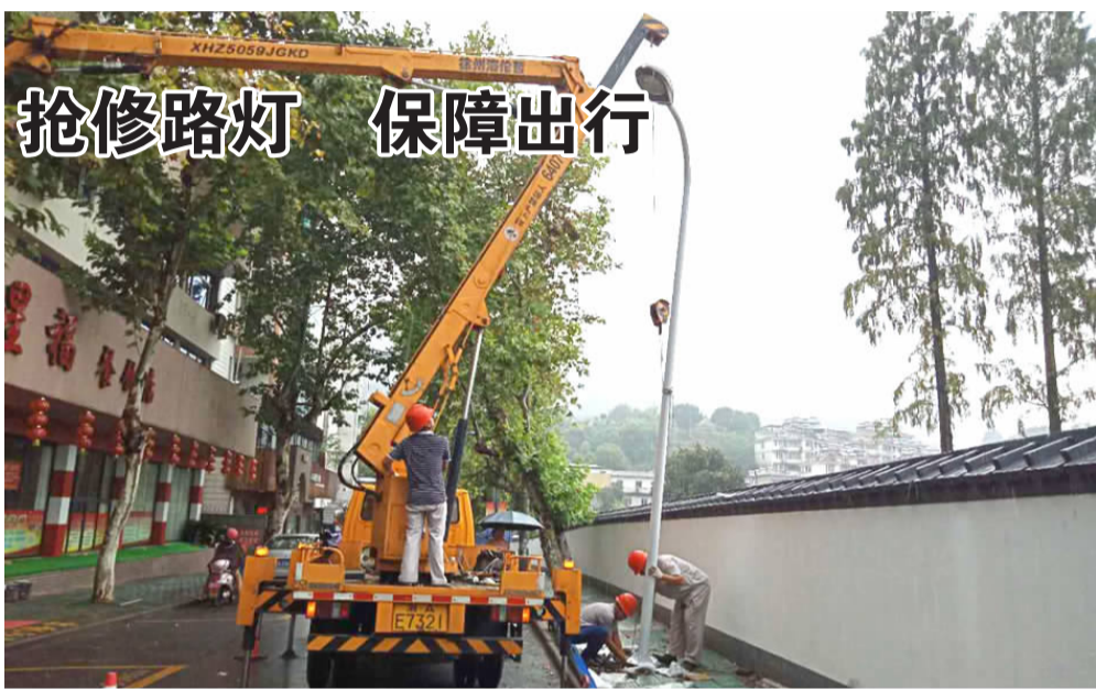
受持续阴雨天气等影响，新安江主城区路灯设施不同程度出现故障。连日来，市新安城市照明管理有限公司工作人员冒雨抢修320国道建德隧道、白沙大桥、中兴南路等路段的故障路灯，以保障市民的安全出行。
