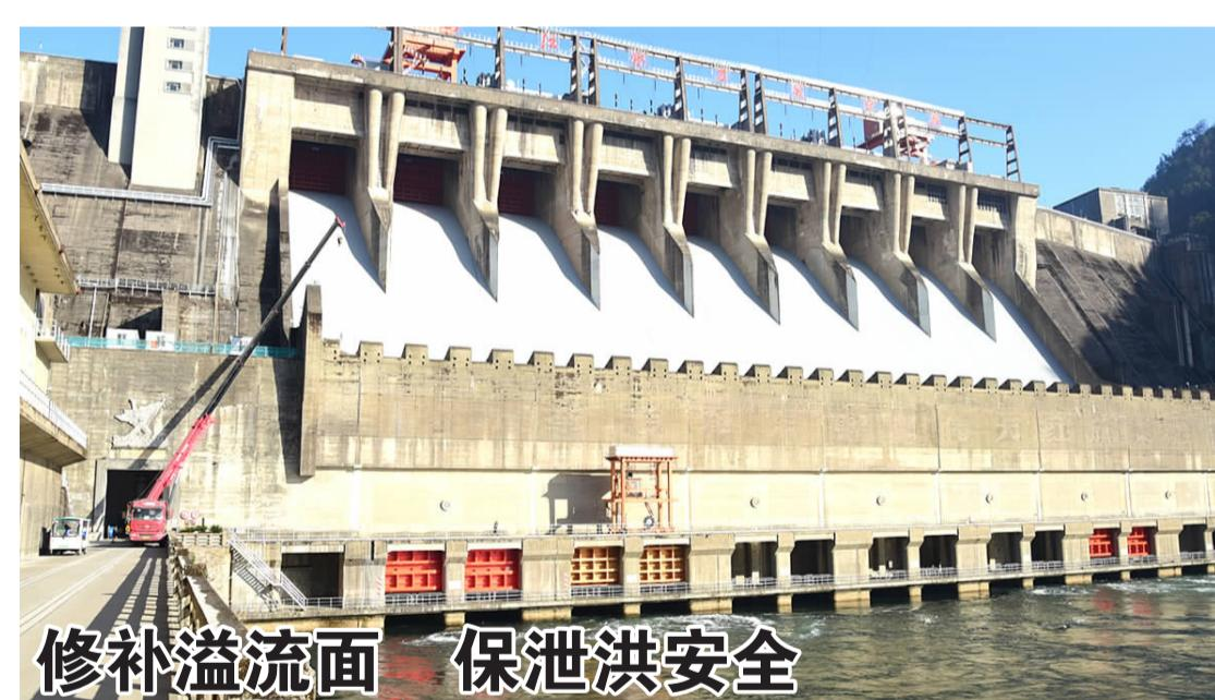
昨日，施工技术人员正在对新安江水库大坝溢流面进行最后的修补涂料阶段施工。从2020年10月起，新安江电厂技术人员开始对大坝溢流面的缺陷采取抗冲磨及耐久性防护技术
