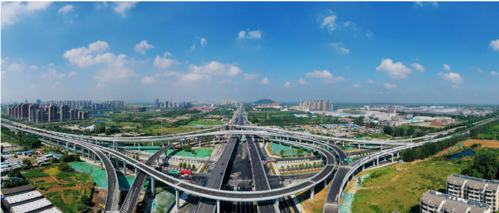
图为8月31日拍摄的互通立交，建设者们加紧施工，确保项目早日建成。近日，G312合六路（南岗镇—侯店路）项目方兴大道互通立交结构全线贯通。接下来，互通立交将进行桥面附属工程及地面道路施工，预计10月份放行通车。作为G312合六路快速化改造工程的重要节点，合六路与方兴大道互通立交主要包含合六路主线高架及8条匝道，共5层。建成后，该交口将极大改善合六路的通行能力和服务水平，加强合肥市主城区与六安城际之间的交通联系，对改善沿线群众生活条件、促进区域经济发展、提升城市品质具有十分重要意义。
