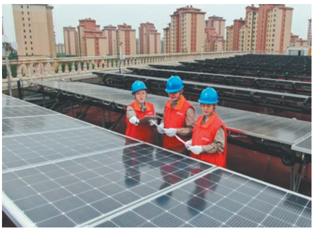
国网天津滨海供电公司工作人员正在对光伏设备巡视。
