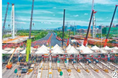
在 150 余台机械的轰鸣声中,中铁四局日前对跨深高速的南京江宁月华路桥、南京收费站大棚实施机械拆除,保障南沿江城际铁路按期通车运营。图 1:华路桥实施机械拆除。图 2:拆除南京收费站大棚。
