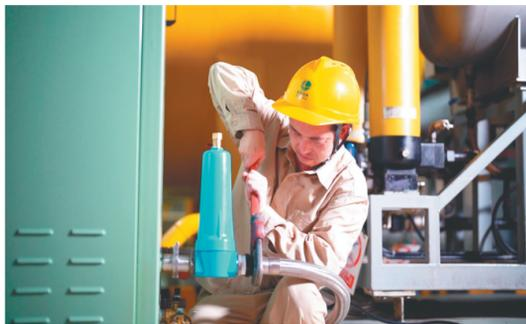
方天公司技术人员正在安装滤油机进油管道。
