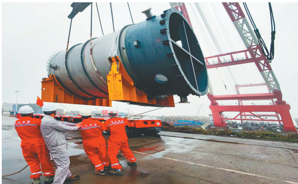
11月19日,仪征化纤公司年产300万吨PTA项目首台80吨重的精馏塔回流罐对接圆满成功,预示着该项目建设进入到大型设备全面安装阶段。据了解,仪化PTA项目是江苏省重大项目、中国石化重点工程,共需搬运大型设备50多套,总重达14500余吨。 刘玉福 翟瑞龙 摄
