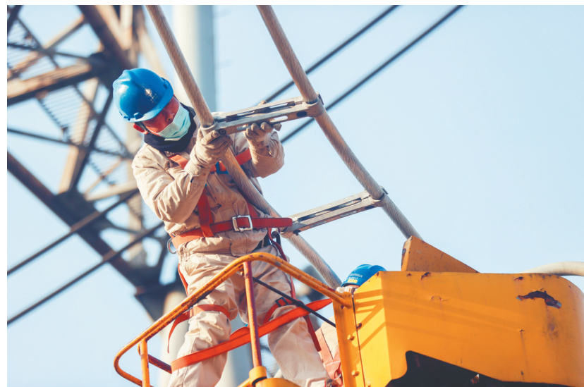
1月18日,在500千伏车坊变电站检修现场,江苏省送变电有限公司施工人员正在对设备进行全面检修,全力保障春节期间人民群众用电需求。史俊 摄
