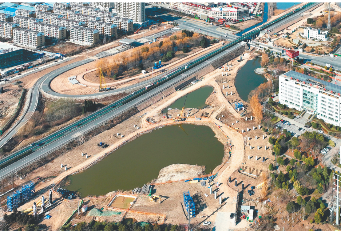
长深高速公路连云港至淮安段扩建工程日前全线开工建设。连淮高速扩建工程起自连云港市海州区宁海枢纽北,止于淮安市淮阴区王兴枢纽北,全长约98.65公里,总投资约160.31亿元。全线扩建后将由双向四车道扩为双向八车道,设计速度120公里/小时,建设工期三年半。图为无人机在灌南县境内拍摄的连淮高速扩建工程现场。耿玉和 摄
