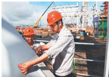
7月18日,公司员工对#1炉钢架斜撑尺寸复核。
