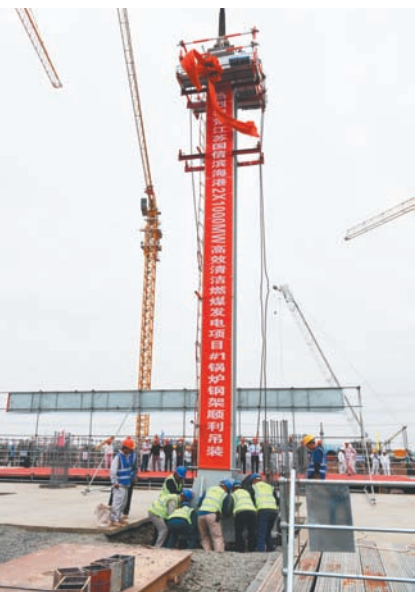
5月6日,江苏国信滨海港2×1000MW高效清洁燃煤发电项目1号锅炉首根钢架成功吊装。
