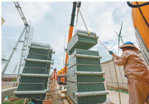
9月4日，江苏金湖县供电公司组织施工人员正在塔集镇横桥社区安装110千伏荷花变电站1.2号主变。110千伏荷花变电站本期建设2台主变63兆伏安，主要解决荷花荡景区电力负荷日益增长需求，改善电网结构，提高电网运行可靠性。该项目于今年2月份开工建设，计划12月份建成投运。梁德斌 摄
