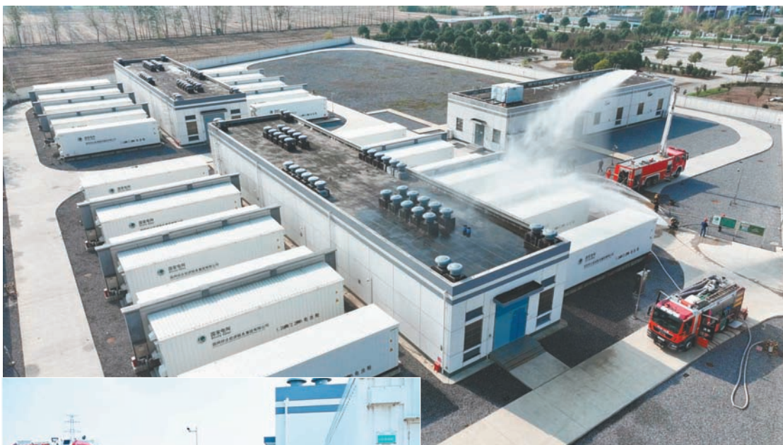
11月14日,淮安市金湖县银涂镇红湖储能电站,消防人员正在对2号电池预制舱进行灭火演习。红湖储能电站是国家电网公司在金湖县试点建设的新型电力系统项目之一,该站建设规模40.32兆瓦/70.4兆瓦时,每天最高可提供约140兆瓦时错峰电量。当日,国网金湖县供电公司联合金湖县消防救援大队模拟2号电池预制舱突发火灾事故进行救援演习,进一步提升储能电站安全运行水平。梁德斌 摄
