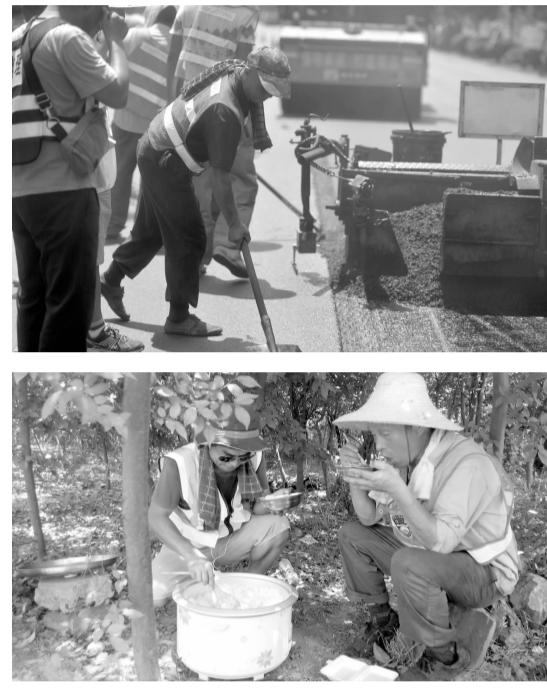
“啊呀，160℃了！”当工人把专用的温度计插入沥青，看到刻度显示直线上升，记者不禁惊呼起来。“我们必须穿专用的胶底鞋，鞋子里还要垫上棉垫子，可以隔热不烫脚。鞋子穿得不对，踩上去就会烫出泡。”长袖长裤、草帽、胶鞋，全副武装的贾维鹏干这行已经10多年，经验丰富。摊铺机缓慢前行，贾维鹏将散落的沥青铲起重重新拍入沥青层。碰到没有摊铺到沥青的路沿，他还要迅速从车里挖来沥青铺路沿，使其平整。贾维鹏的工作服早已湿透，搭在脖子上的毛巾也可以拧出水来。由于是隔挡半幅路面施工，除了高温，施工人员还要忍受身边飞驰而过的车辆噪音和尾气。
