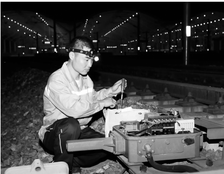
祁超夜间精心调试道岔设备。
