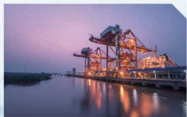
句容发电厂卸煤码头
