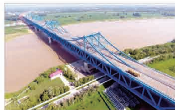
石济铁路黄河公铁两用桥
