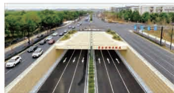
杭州市紫金港路改造提升工程
