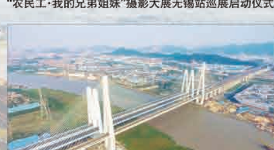
宁波铁路枢纽北环线甬江特大桥主桥
