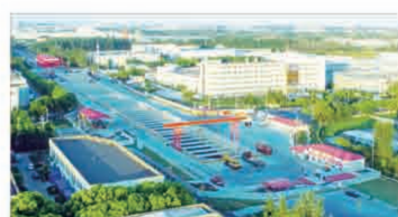
无锡地铁3号线长江路站
