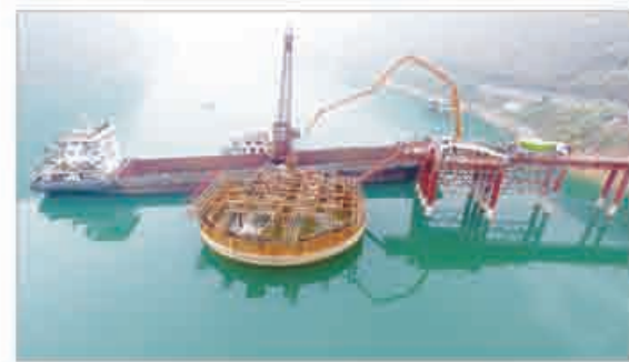
渝怀铁路涪秀二线乌江右线特大桥
