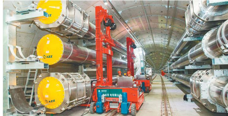
苏通GIL综合管廊工程,起于南岸(苏州)引接站,止于北岸(南通)引接站,全长5468.5米,是目前世界上电 压等级最高、输送容量最大、技术水平最先进的超长距离GIL创新工程,也是长江上首条包含了电力、通信、有线 电视等市政管线的综合管廊,被称为"万里长江第一廊"。该管廊工程2016年8月开工建设,今年9月底建成投 运,向国庆七十周年献礼。
