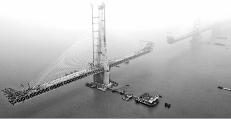
由中铁铁路总公司建设、中铁大桥局设计、中铁大桥局施工的沪通长江大桥南主塔日前成功封顶。至此，大桥两座高达330米的主塔全部建成。沪通长江公铁两用大桥全长11072米，主桥长2296米，主跨1092米，为国内最大跨度斜拉桥，也是世界上首座跨度超千米的公铁两用斜拉桥。
