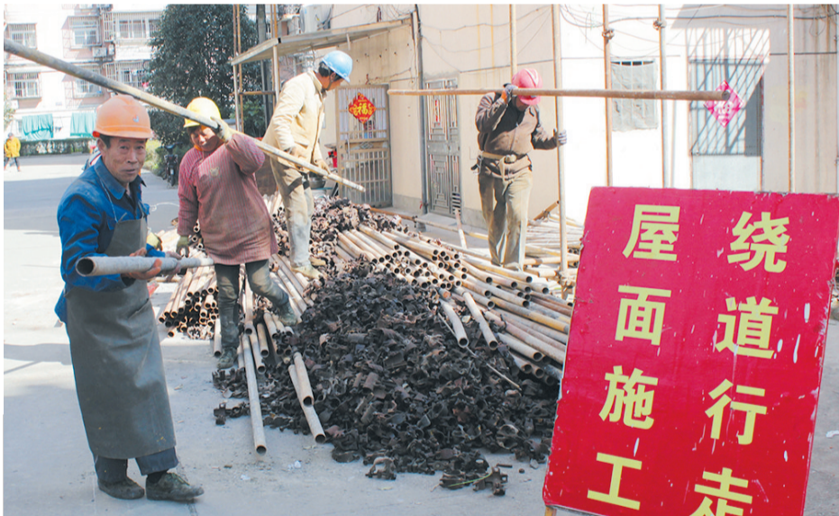
近日，康华新村、康华二村、王家舍老旧小区改造工程进展顺利，紧张开展屋面维修与外立面、外挂线管等捆绑出新等工作。图为施工现场。范前锋 摄
