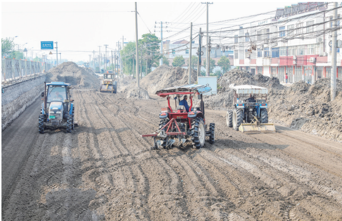
姜沈路拓宽工程全长9.5公里，改造桥梁7座，今年拟完成50%路基土方工程，预计明年底建成，将更好地方便群众出行、服务农业园区发展。图为施工现场。
