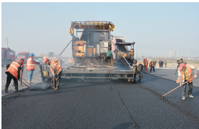
昨日上午,长江西路(上海路—双登大道)新建工程进入面层沥青摊铺阶段,投入4台大型摊铺机、6台压路机,组织50多名施工人员,抢抓晴好天气,全力以赴加快施工进度,预计月底完工,通车后将极大方便市民出行。
