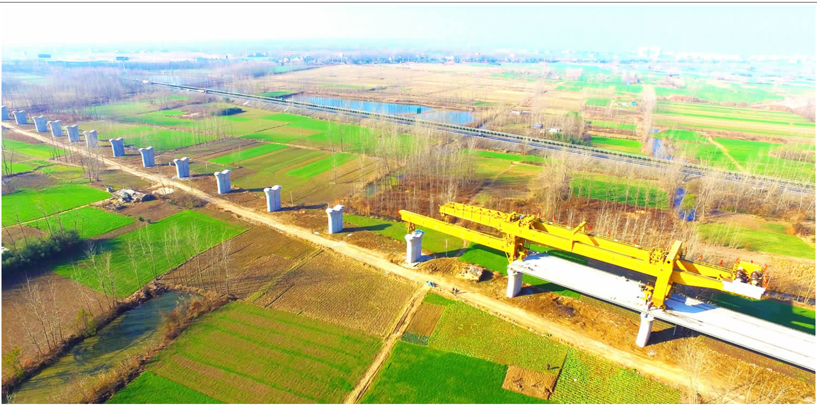
日前,记者在连淮扬镇铁路涟水蒋庵段看到,高铁建设现场一派忙碌的景象,制梁厂内,166片高大的混凝土箱梁已制作完毕,架梁机正以每天2~3片的速度架设着箱梁,目前已完成20余片箱梁的架设。据了解,涟水境内的箱梁架设最早将于明年年底全部完工。图为架梁机正在有序地架设高铁箱梁。
