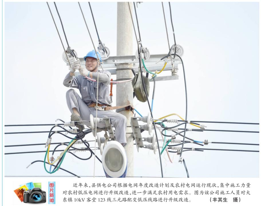
近年来,县供电公司根据电网年度改造计划及农村电网运行现状,集中施工力量对农村低压电网进行升级改造,进一步满足农村用电需求。图为该工程施工人员对大东镇 10kV 客堂 123 线三路配变低压线路进行升级改造。
