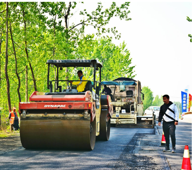
时下气温回暖,我县部分公路进入春融病害高发期,近日,县交通运输局养护公司利用当前晴好天气,组织人员、机械对公路出现的坑槽、塌陷、裂缝、壅包及路肩坑洼等病害进行集中修补。图为工作人员对破损的连高路段进行维修。(朱惠莉 杨海燕 摄)
