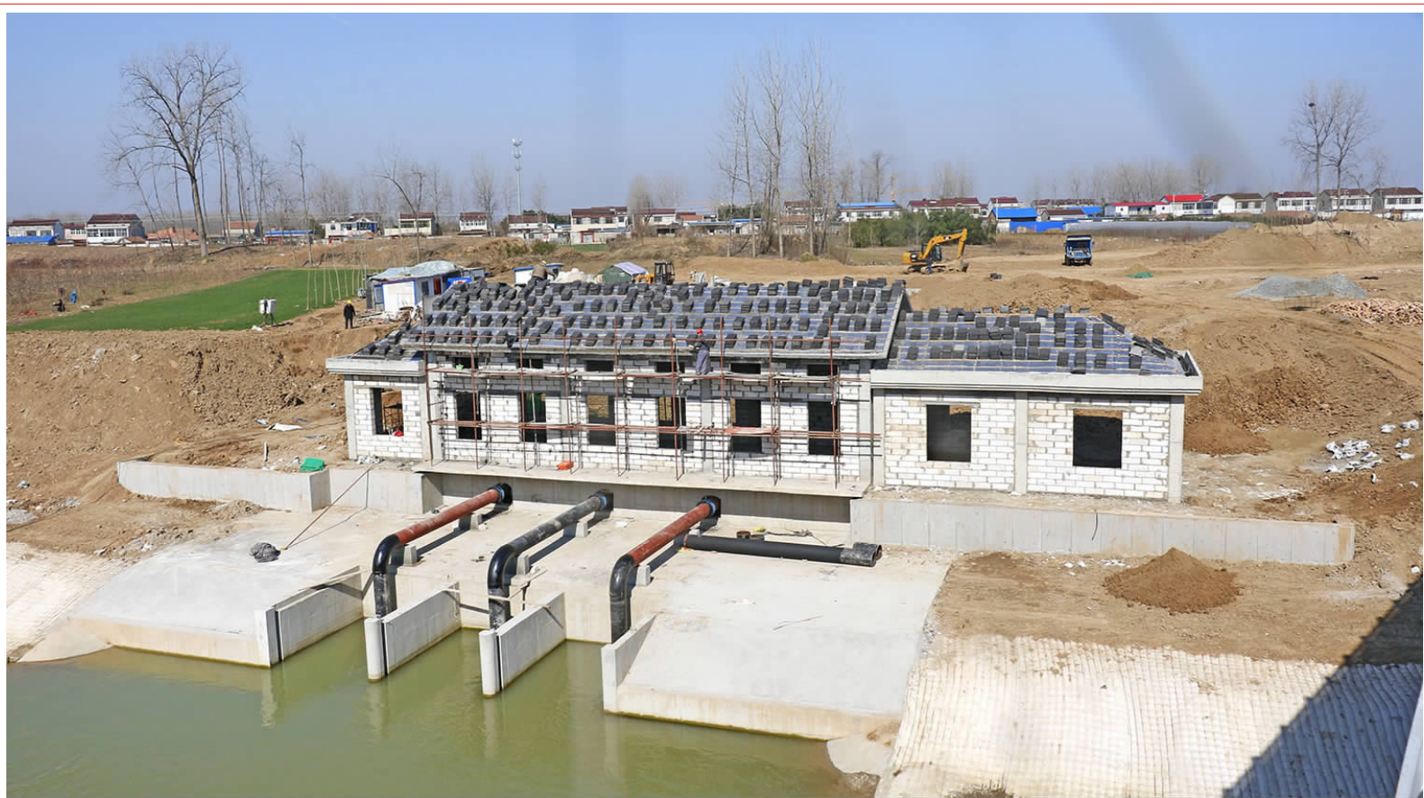
涟水湖备用水源地引水工程为我县备用水源地建设的重要组成部分,该工程总投资约2000万元,项目包括新建提水泵站1座、输水管道2.2公里、顶管施工2处。目前,提水泵站水下工程已经完成,3台水泵机组正在安装。(潘曼摄)
