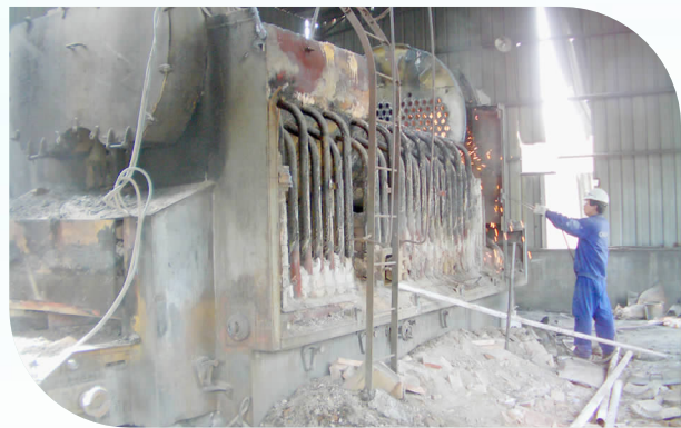
对燃煤锅炉进行拆除
