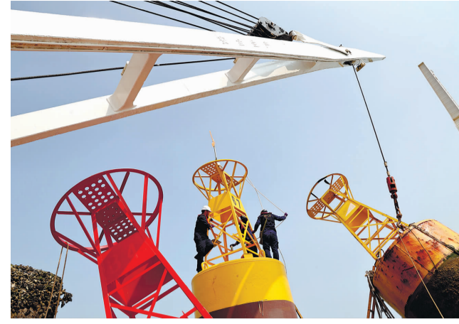
日前,交通运输部东海航海保障中心连云港航标处组织海巡169轮,对港区海域内锈蚀严重的67号灯浮标进行更换,有效保障连云港港主航道通航安全。
