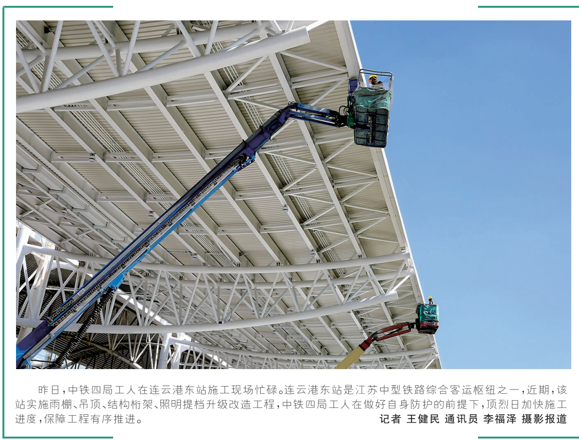
昨日,中铁四局工人在连云港东站施工现场忙碌。连云港东站是江苏中型铁路综合客运枢纽之一,近期,该站实施雨棚、吊顶、结构桁架、照明提档升级改造,中铁四局工人在做好自身防护的前提下,顶烈日加快施工进度,保障工程有序推进。
