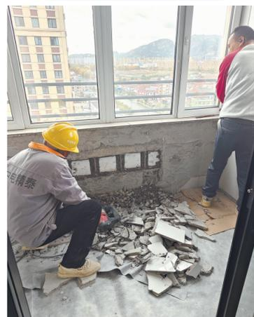
工人正在拆除阳台墙砖，准备做阳台防水
