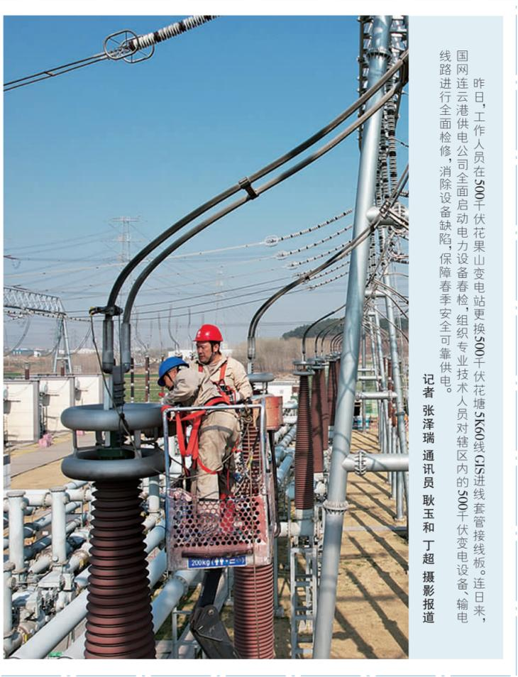
昨日,工作人员在500千伏花果山变电站更换500千伏花塘5K63线GIS进线套管接线板。连日来,国网连云港供电公司全面启动电力设备春季检修,组织专业技术人员对辖区内的500千伏变电站设备、输电线路进行全面检修,消除设备缺陷,保障春季安全可靠供电。
