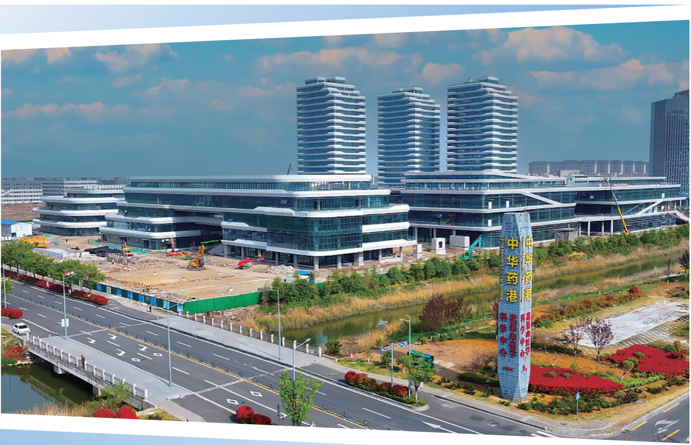
近期,中华药港“药港新天地”项目建设正酣。作为中华药港三期工程,该项目聚焦生活与商业配套服务,建成后将与一期产业先导区、二期高端化学制剂产业园协同联动,构建“服务生态圈+产业集聚极”格局,打造“生产、生活、生态”融合的创新创业产城示范园区。目前,该项目整体单体外立面幕墙装修已完工,室内装修方案持续优化,室外景观工程同步推进。按计划,“药港新天地”将于今年下半年竣工。图为正在加快推进建设中的药港新天地。(沈超)
