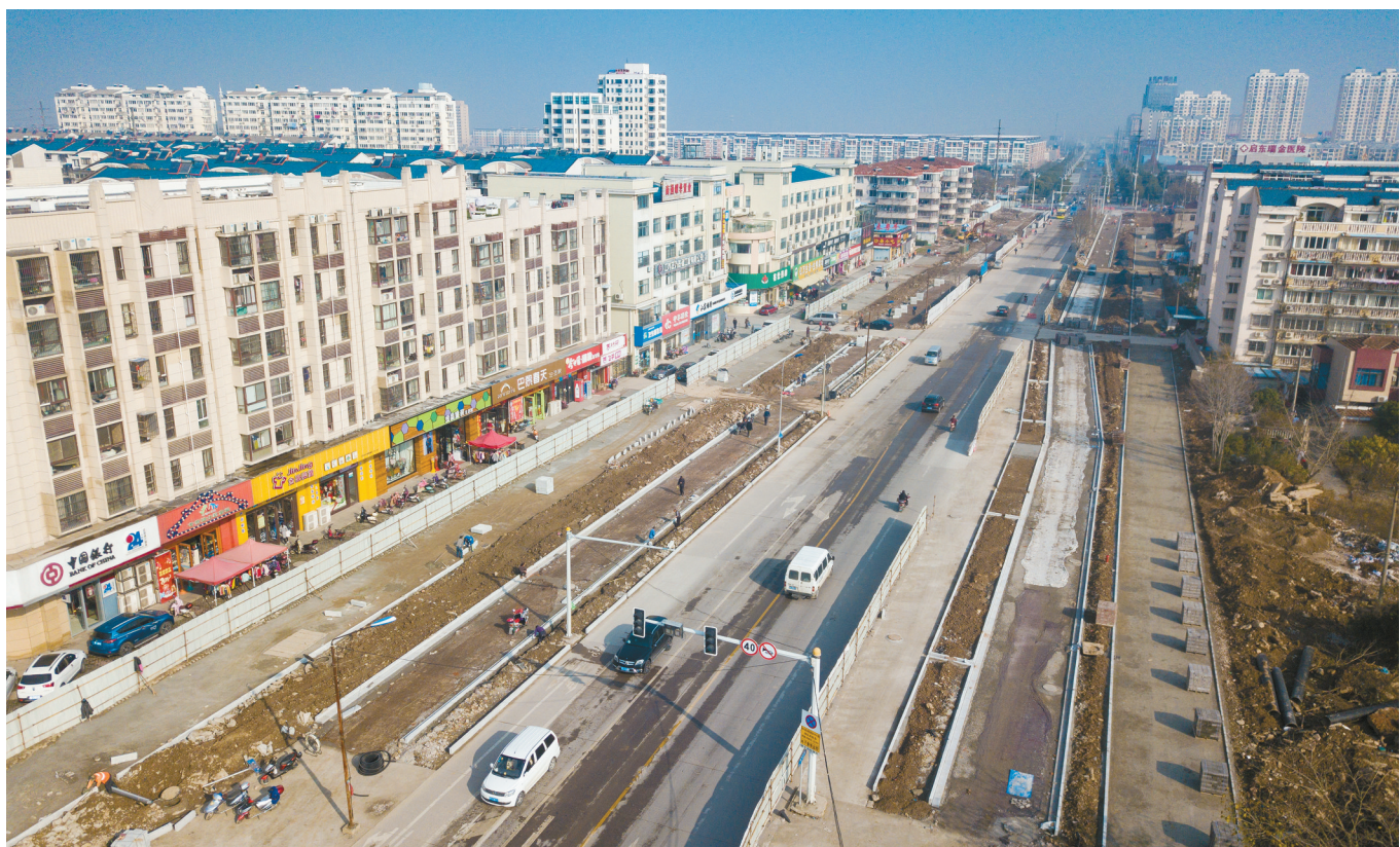
12月19日,和平路(长江路-紫薇路)改造工程如火如荼,正在进行非机动车道路沿石和人行道的铺设。该路建成后为双向四车道,路面宽度从之前的16米增加至50米,将大大提高道路的通行效率。预计2019年1月下旬改造完成。姜雨蒙摄
