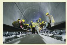
日,衢宁铁路(遂昌 段)首组500米轨排 从铺轨机组中缓缓拖 出,稳稳下落在常乐 」隧道内。该组轨排 的成功铺设,标志着 衢宁铁路(遂昌段)全 线正式进入铺轨阶 段,向2020年全线通
