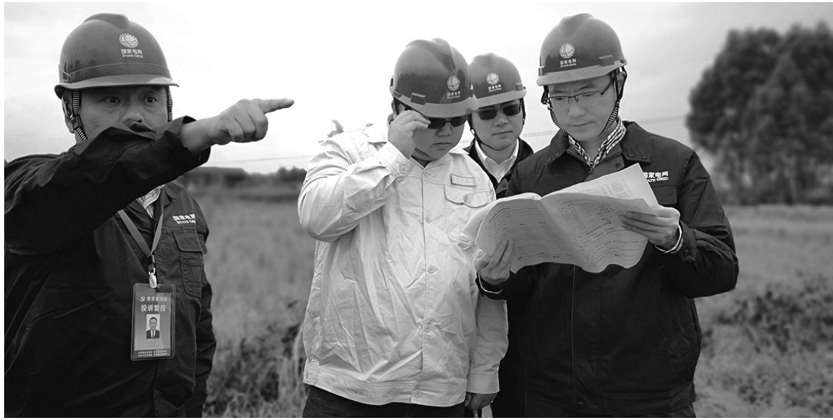
配电网一体化检修现场
