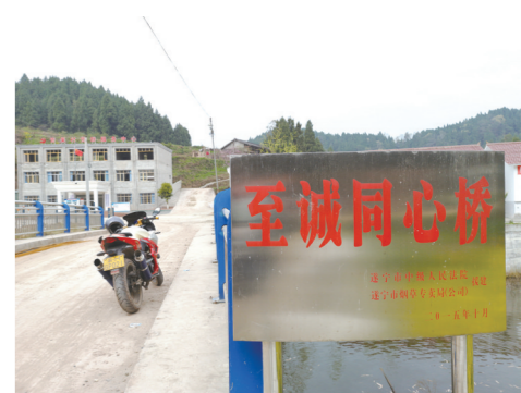
遂宁烟草援建当地的桥梁设施
