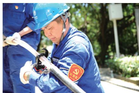
共产党员服务队开展电力检修工作
