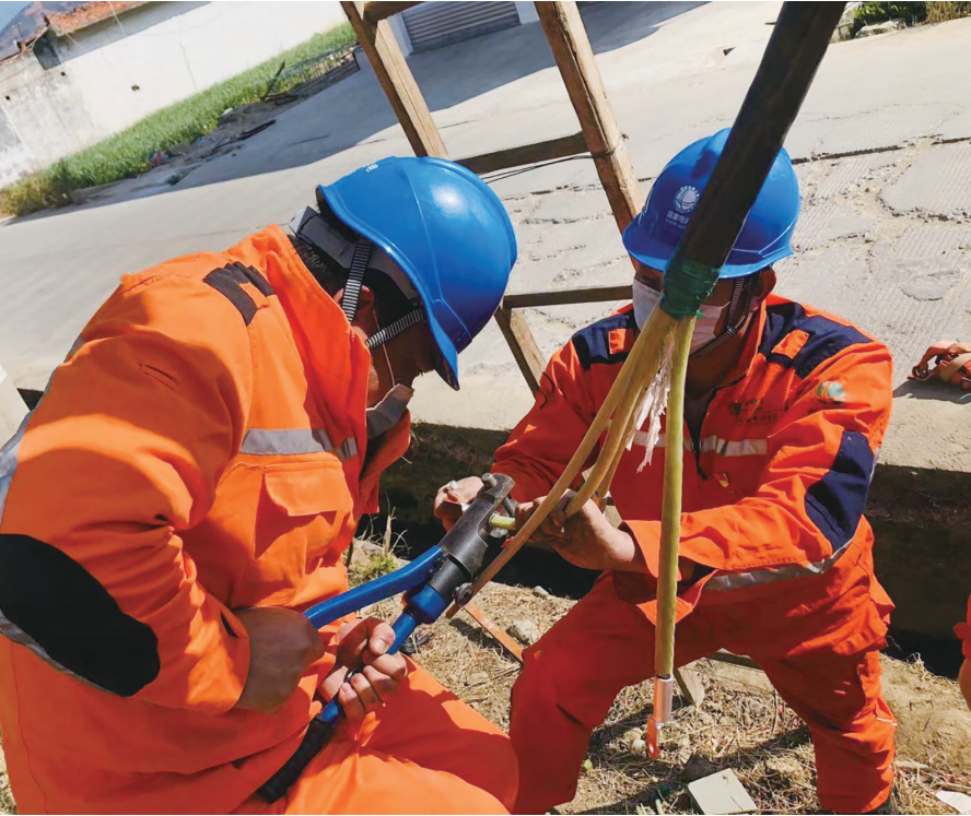
凉山供电公司工作人员在临时隔离点进行线路搭接
