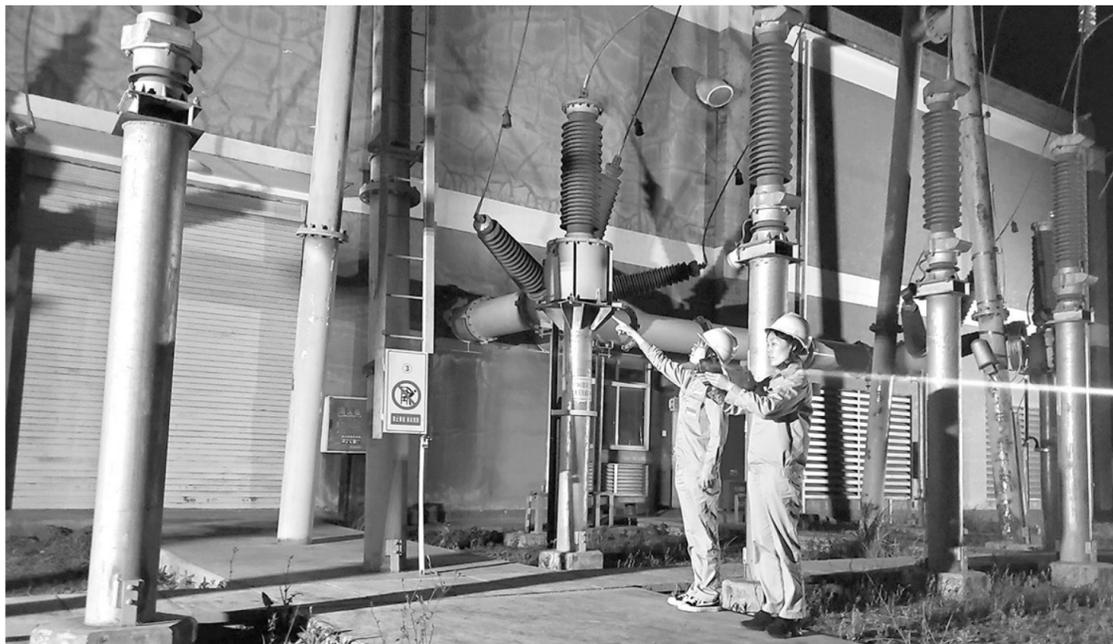
运维人员对卫星发射相关变电站进行红外测温特巡
