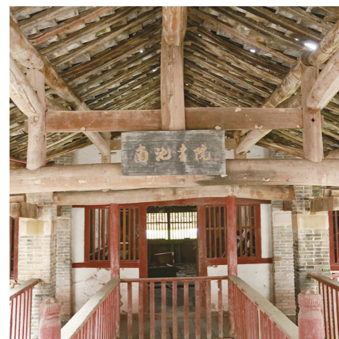
维修前的南池书院内景
