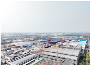
启非凡电子项目当期计划投资3亿元,主要生产智能充电枪,招引单位为泗洪县委办(产权证号:泗洪第***4781号)
