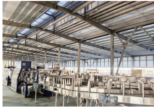
锦鸿兴汉生物项目完成投资2亿元,主要生产苏打水、奶制品,招引单位为沐阳县供电公司
