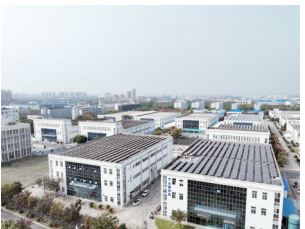
台硕科技项目当期计划投资1亿元,主要生产二极管,招引单位为泗洪经济开发区(产权证号:泗洪第***6722号)
