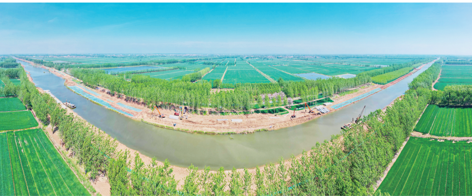
4月25日，在宿连航道古泊河段施工现场，打桩机、螺旋钻机、挖掘机以及挖泥船等大型设备紧密配合，不断加快宿连航道二期工程建设进度。据了解，宿连航道作为江苏省“两纵五横”主骨架中“最北一横”，是实现海河联运的重要水运通道，是百公里航道、百亿元投资的“双百”工程。 郑绪军 陶松杨 摄
