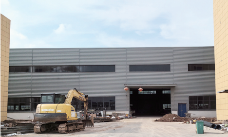
智之峰新能源项目当期计划投资3亿元,主要生产智能移动卫生间、智能垃圾分类设备,位于沐阳经开区
