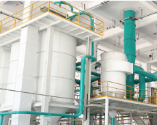
鑫源昌重工项目当期计划投资13亿元,主要生产钢箱梁、异形钢模板,位于常熟泗洪工业园区
