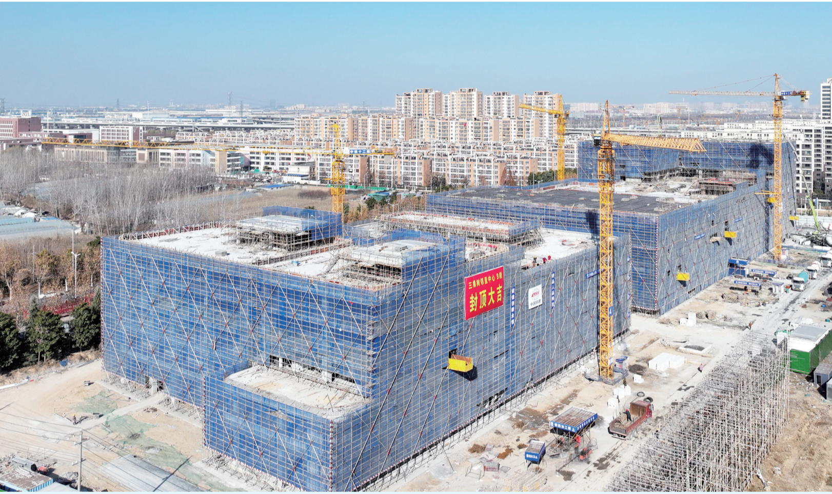
近日,宿迁经开区三棵树邻里中心项目顺利完成主体结构封顶,标志着项目建设迈入新阶段。自2024年8月份开工建设以来,该项目坚持“安全警钟长鸣,质量速度并进”的施工理念,倒排工期,挂图作战,拉满建设“进度条”。项目建成后,将为辖区及周边超过5万居民提供集生活、服务于一体的“一站式”贴心服务,切实提高人民群众获得感和满意度。
