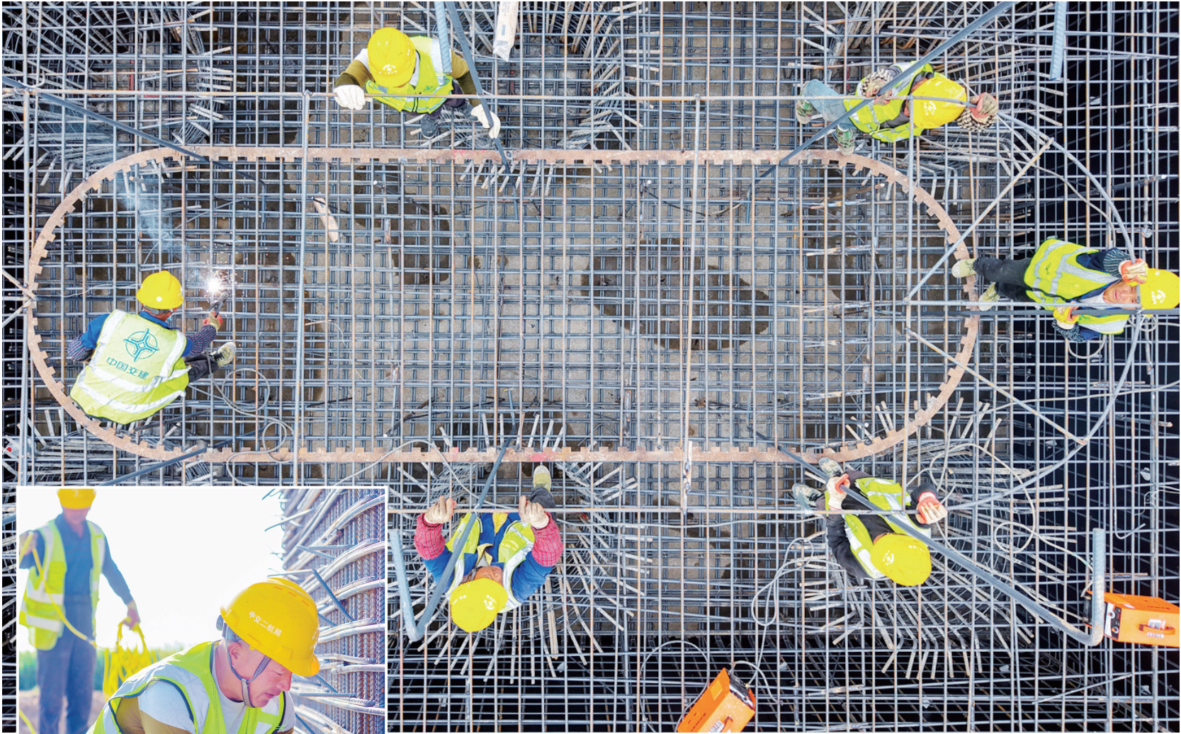
杨占山与工友们齐心协力对钢筋进行焊接和绑扎。
