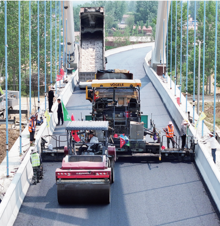
6月9日,建设者在沭阳县耿圩镇境内的宿连航道工程建设现场进行沥青摊铺作业,加快桥梁项目建设进度。 丁华明 摄
