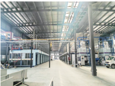
荣汇新材料项目完成投资4亿元,主要生产新型包装材料,招引单位为泗洪县住建局
