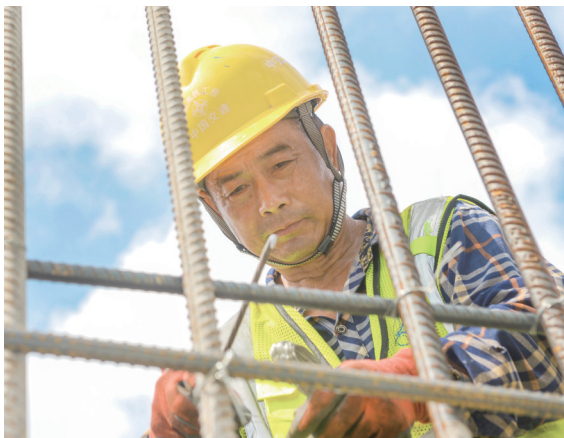
7月9日,在宿淮高铁宿迁段施工现场,工人正在绑扎钢筋。 王帅甫 摄
