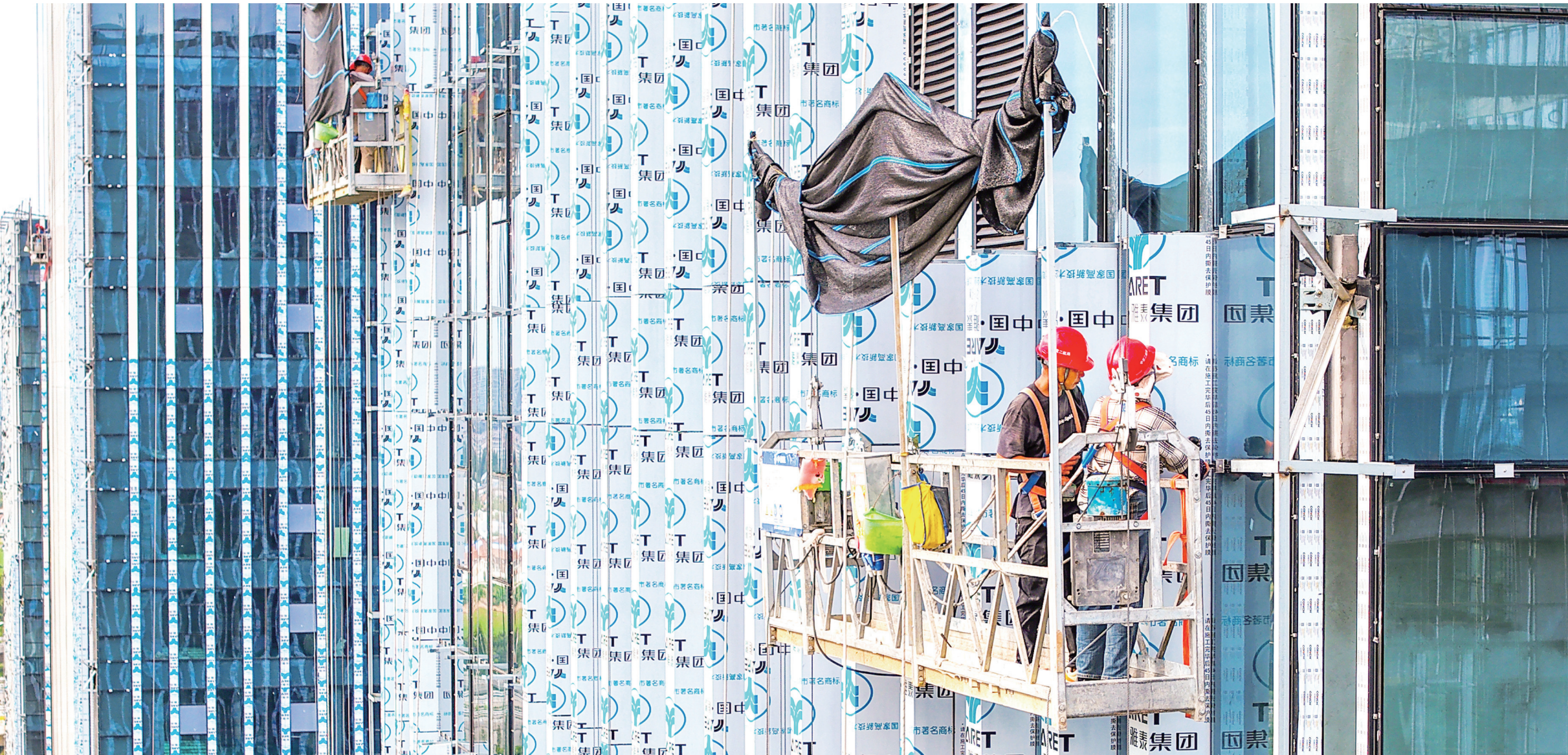
7月8日,在宿迁高新区北斗智能终端制造产业园项目施工现场,工人正在安装幕墙。
