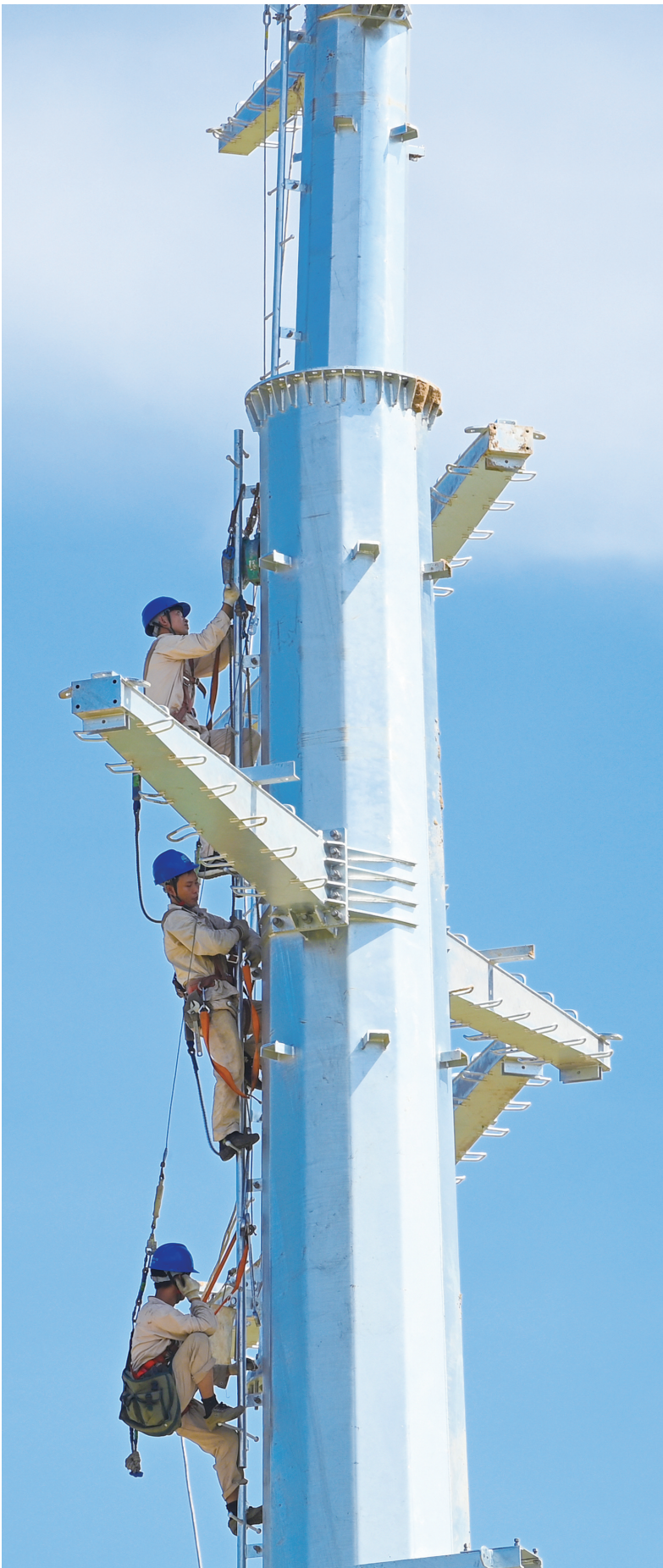
7月8日,在宿城区七里大道路旁,电力工人正在安装杆塔。
